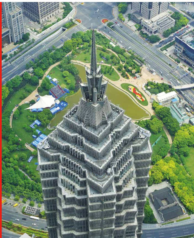
为上海最著名的摩天大楼之一——金茂大厦提供能源和照明电缆。
